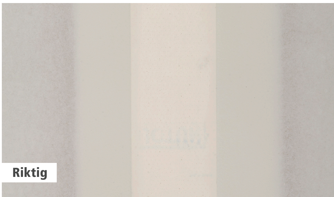
Korrekt utført innsparkling av sparkelremse. Sparkelremsen er presset godt inn mot gipsplaten i skjøtforsenkningen.
